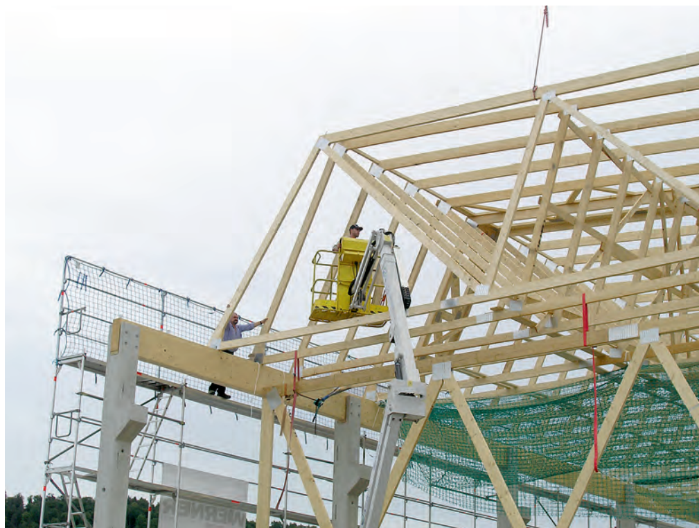
1 | Montage eines weit spannenden Nagelplattenbinders für ein Hallendach. Die verhältnismäßig schlanken Dimensionen der Holzstäbe weisen auf eine optimale Ausnutzung der Festigkeiten von Holz und Nagelplatten hin. Voraussetzung für das „Funktionieren“ der Konstruktion ist hohe Sorgfalt bei Herstellung, Transport und Montage.
