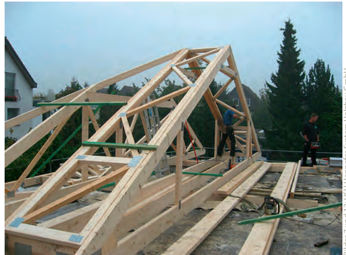
Bilder 7 und 12: HSH Hemmeyer System Holzbau GmbH
