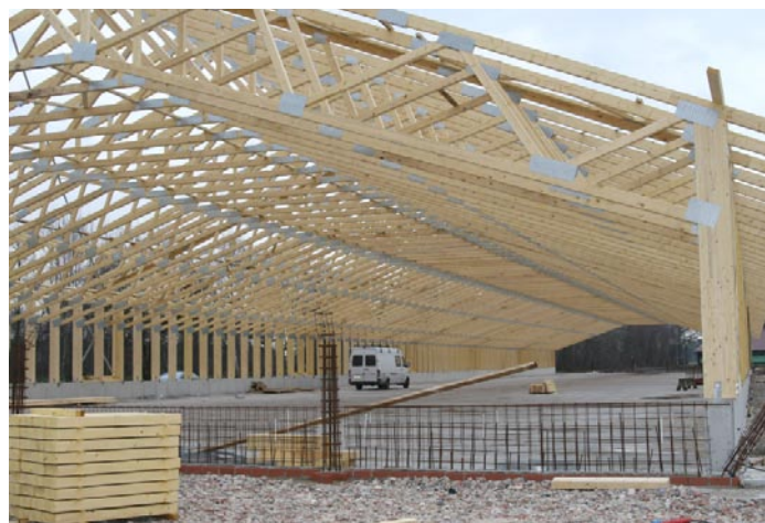
▲ Da Nagelplattenbinder der GIN-Betriebe aus technisch getrocknetem Holz hergestellt sind, brauchen sie keinen chemischen Holzschutz
