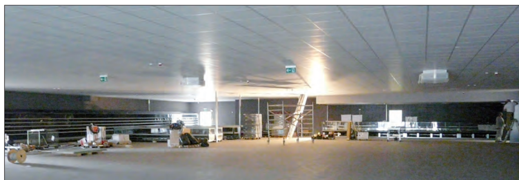
... und der Blick in das Erdgeschoss derselben (Opitz-)Baustelle: eine 35 x 52 m messende stützenfreie Grundfläche. Der Marktbetreiber ist bei der Einrichtung durch keinen Pfeiler eingeschränkt.
