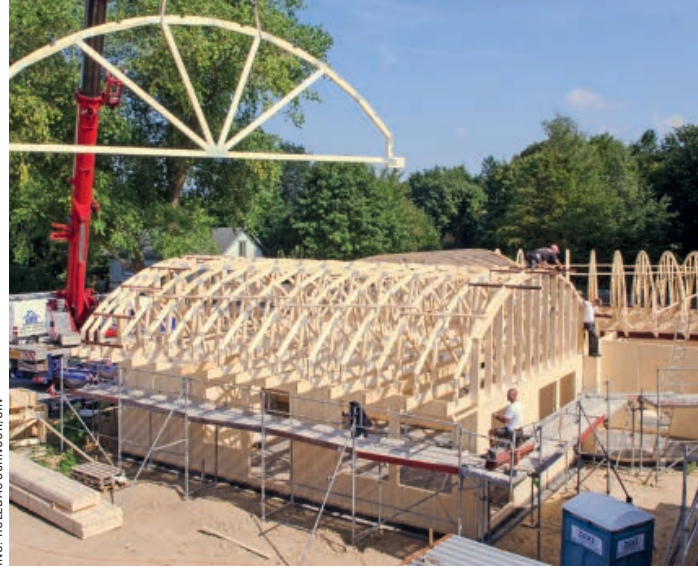
Mit Nagelplattenbindern lassen sich unterschiedlichste Dachformen realisieren
