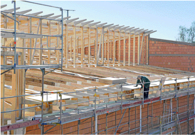
Für den wirtschaftlichen Objektbau bieten sich Dachtragwerke aus maßgenau vorgefertigten Nagelplattenbindern an. Die Binderkonstruktionen sind für Spannweiten bis 35 m bauaufsichtlich zugelassen
