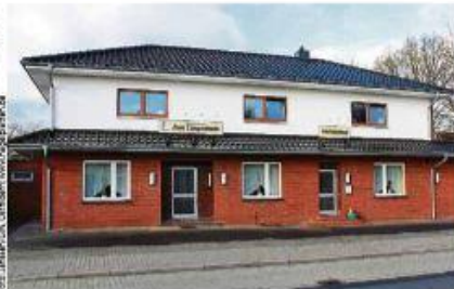
Komplett neu eingedeckt und frisch wippat, bildet das altaltin gestaltete Übergeschoss dieses Gasthauses im ostfildrischen Weite einen Kontrast zur geklärten Erdgeschoss-Fassade.
