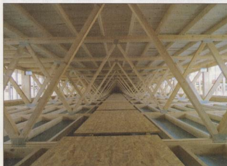
Die Tragwerkkonstruktion der aktuellen Aufstockung des ehemaligen Quelle-Verstandhauses in Nürnberg („TM50“) wurde gewichtsoptimiert mit robusten Nagelplattenbindern ausgeführt Foto: DHV/Holzunion
