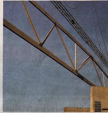
Große Distanzen freitragend überspannen: Auch die Dächer von Bürogebäuden und Lagerhallen, die über die erforderliche statische Belastbarkeit verfügen, kommen als bebaubarer Grund für Geschossaufstockungen mit Nagelplattenkonstruktionen in Betracht.
