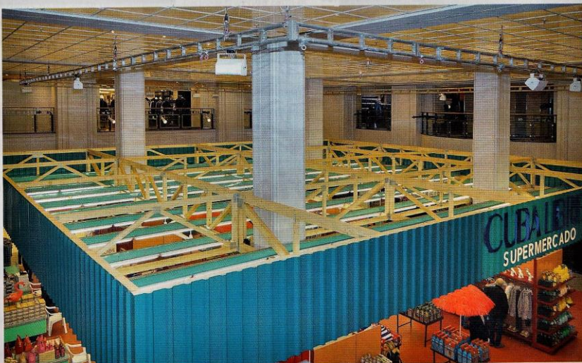
Neun jeweils 17 m lange Nagelplattenbinder bilden das Tragwerk einer temporären Sonderkonstruktion und überspannen eine Verkaufsfläche im Lichthof des Berliner Kaufhauses KaDeWe.
