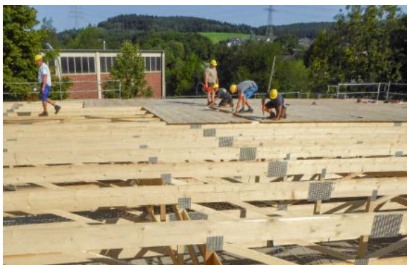
Für Aufstockungen bieten sich Nagelplattenbinder besonders an
