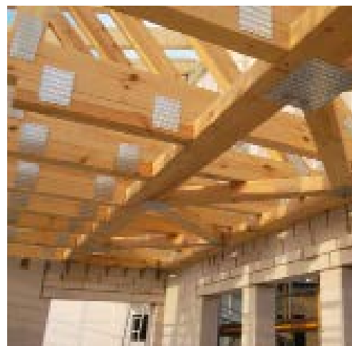
Ein Gasthaus in Norddeutschland wird durch eine Aufstockung erweitert, mit einem Dachtragwerk aus Nagelplattenbindern
