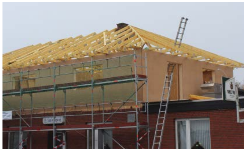
Ein Gasthaus in Norddeutschland wird durch eine Aufstockung erweitert, mit einem Dachtragwerk aus Nagelplattenbindern
