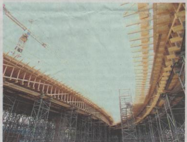
Sicherer Halt für schwere Lasten: Überbauschalungen mit Nagelplattenkonstruktionen kamen unter anderem beim Bau des Autobahnzubringers am Flughafen Köln-Bonn zum Einsatz.
