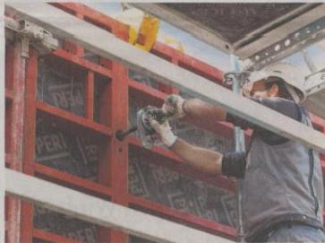
Reduzierter Schalungsaufwand mit Maximo: Geankert wird mithilfe der einseitig bedienbaren MX Anker ohne Mann und ohne zusätzliches Gerüst auf der Gegenseite.
