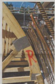
Schalungsbau mit Nagelplattenkonstruktionen: Präzise formbar, hoch belastbar und gleichzeitig kostengünstig sind Schalungen aus Nagelplattenkonstruktionen.
