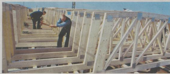
Jeder Schalungsbinder wird bei GIN-Mitgliedsunternehmen im Werk nach Maß vorgefertigt und montagebereit just-in-time auf die Baustelle geliefert.
