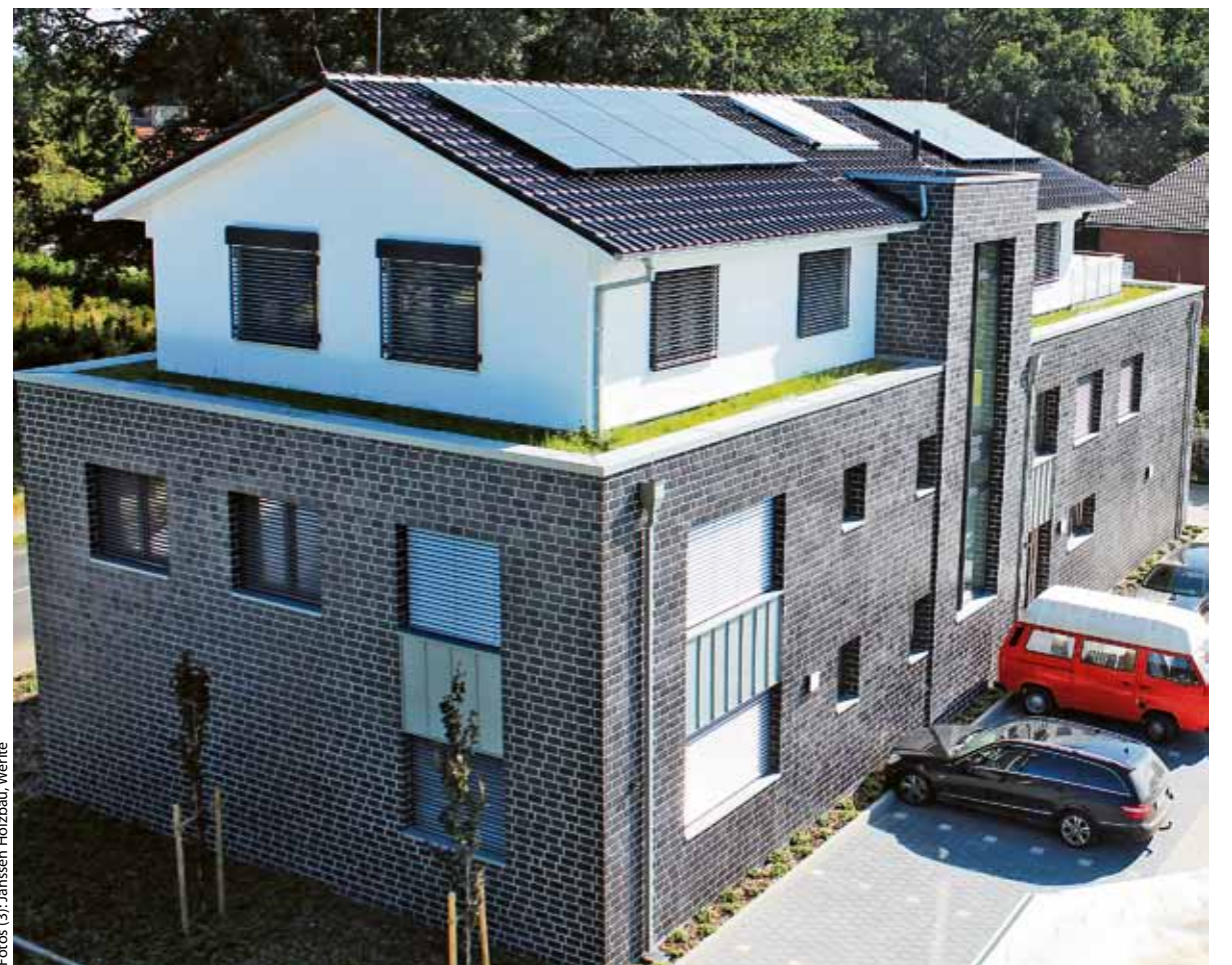
Stattliche Fassade: Der Hohlraum zwischen Mauerwerk und Klinkerschale ist jetzt komplett ausgedämmt, die neuen Vollklinker wurden auf die Altfassade aufgedoppelt.
