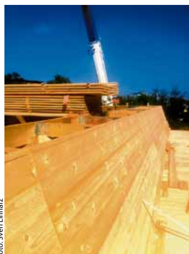
Das Auge sieht nicht alles: Unter der sichtbaren Außenhülle dominiert der Naturwerkstoff Holz. Krug-Holzsystembinder, die das Dachtragwerk bilden, bestehen aus PEFC-zertifiziertem Fichtenholz und bauaufsichtlich zugelassenen Nagelplatten.
