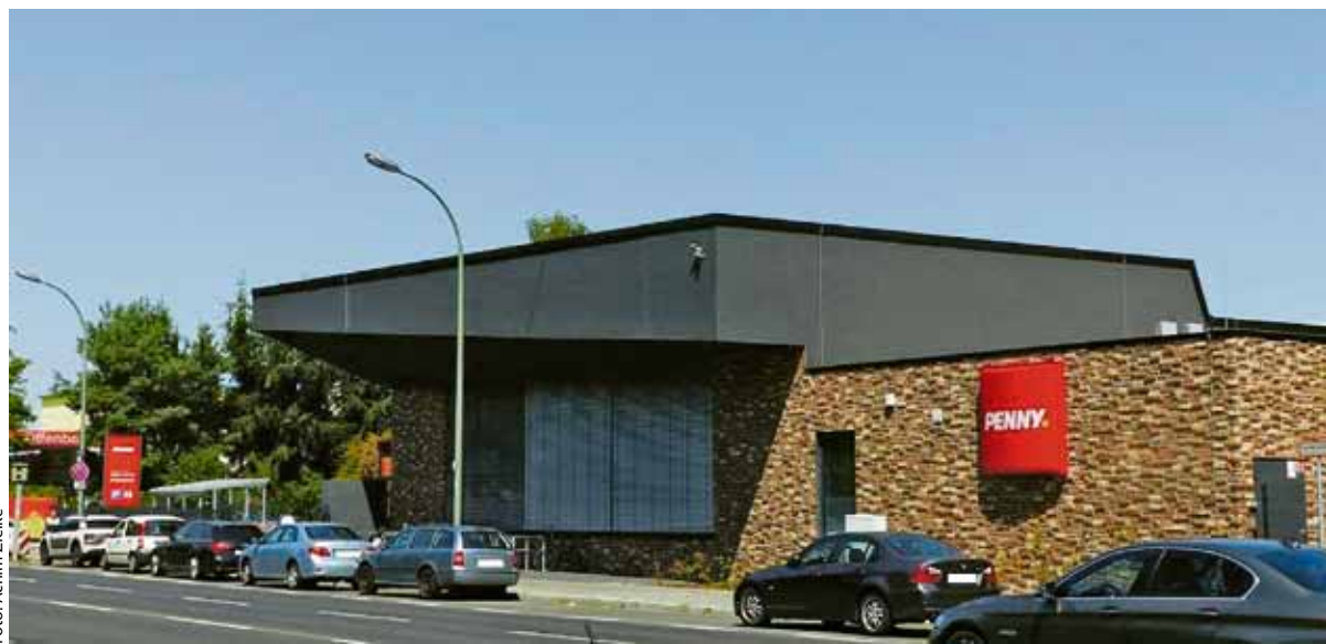
Anthrazit zieht an: Die dunkle Farbe weitestgehend streiflichtfrei zu applizieren, bedingt ein erstklassiges Beschichtungssystem. In Offenbach fiel die Wahl auf Produkte aus dem Hause DAW SE.
