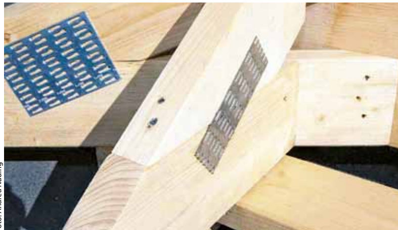
Komplexe Bindergeometrie: Kein Tragwerkselement des Marktes in der Offenbacher Waldstraße gleicht dem anderen. Um die asymmetrische Dachformgebung zu ermöglichen, musste jeder Holzsystembinder im Krug-Werk Stadtlauringen nach spezifischen Maßen angefertigt werden.
