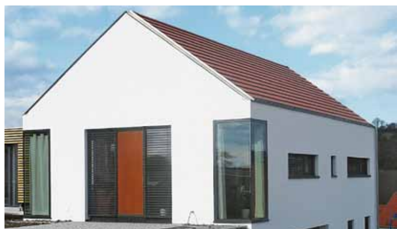
Eine gleichbleibend hohe Qualität der Nagelplattenbinderkonstruktionen ist bei GIN-Mitgliedsbetrieben durch Eigen- und Fremdüberwachungen gesichert. Foto: Krug/GIN
