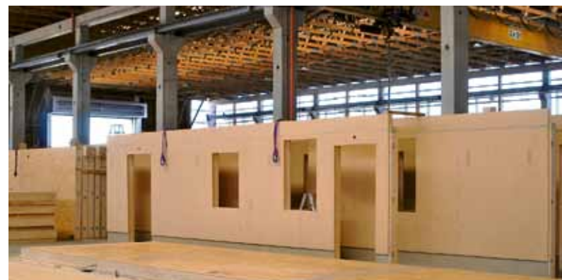
Meisterlich gedämmt: Elemente für die Gebäudehülle werden bei wood stock stock wood-Häusern objektspezifisch vorgefertigt. Zimmereibetriebe, die unter dem neuen Label als Hausanbieter im Markt auftreten, profitieren von den enormen Herstellungskapazitäten im Stammwerk in Werlte.
