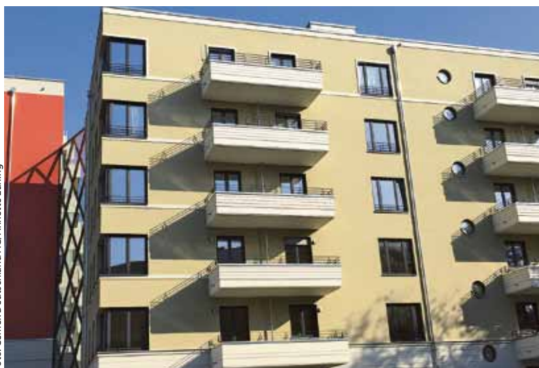
Für den 1. Bauabschnitt hat die Cemex Deutschland AG im Auftrag der Mark A. Krüger Bauunternehmung GmbH etwa 20.000 m 3 Transportbeton geliefert
