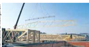
Nagelplattenbinder für den Tragwerksbau müssen – neben Nagelplatten als bauaufsichtlich zugelassenen Holzverbindungsmiteln – grundsätzlich aus technisch getrocknetem, unbehandeltem Nadelholz bestehen ...
