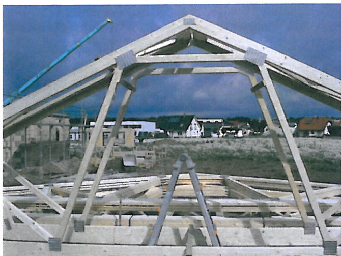
Bild 1 Robuste Nagelplatten-Konstruktion – Nagelplatten werden vor allem im Dach- und Wandbereich von Wohnhäusern, Supermärkten, Gewerbe-, Produktions- und Lagerhallen, landwirtschaftlichen Gebäuden und Sporthallen sowie für Brückenschalungen etc. als extrem belastbare Verbindungsmittel eingesetzt. (Bild: GIN e.V./Krug)
