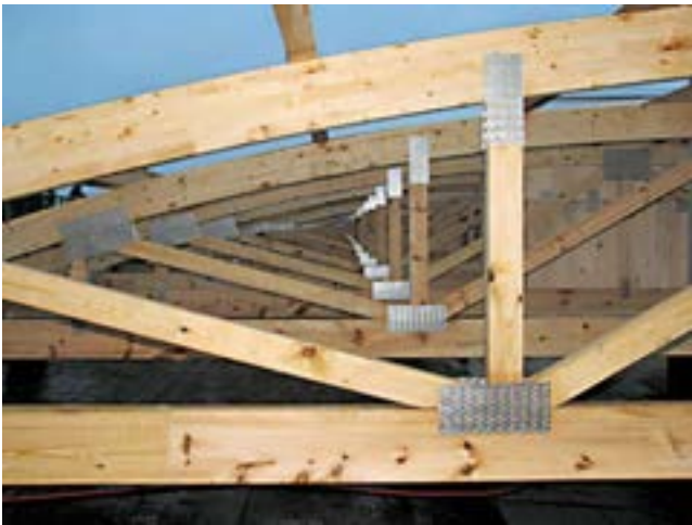
Holzverbund mit Nagelplatten
