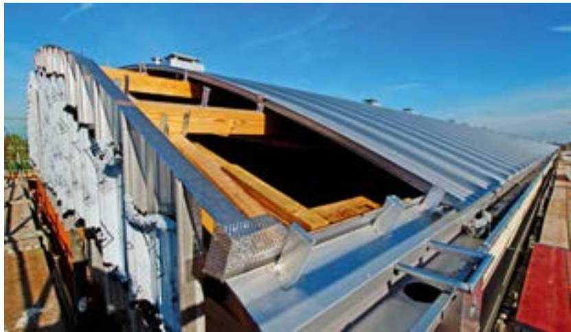
Die Nagelplattenbinder werden mit Aluminiumdachplatten verkleidet
